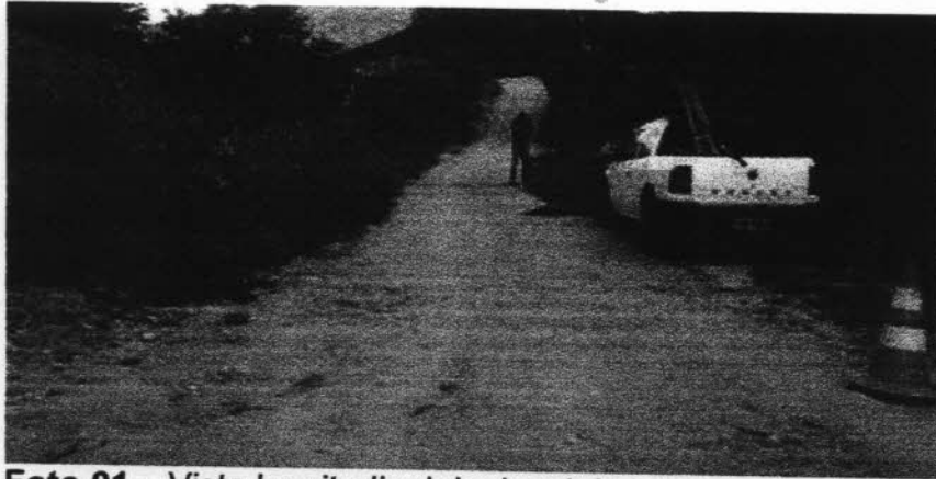
Foto 01 – Vista longitudinal do local de intervenção da obra observado nas proximidades de S 01, na encosta esquerda.
